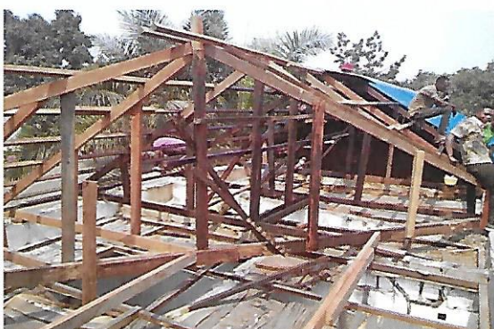
Toit de la maison de vie
